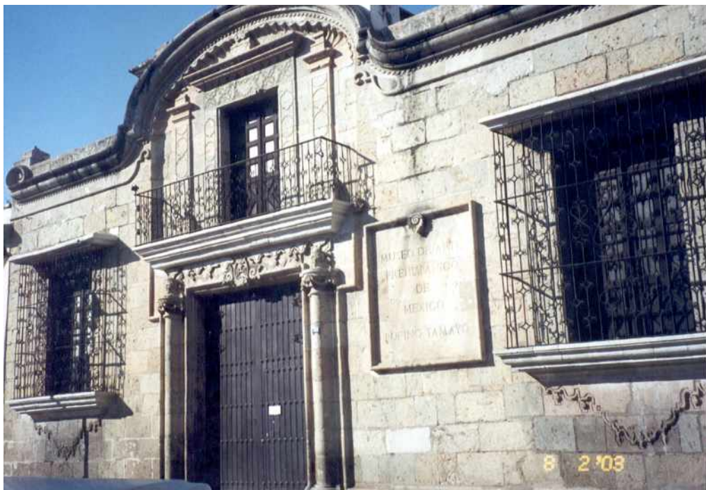
Foto 4. Fachada del edificio colonial que alberga al Museo de Arte Prehispánico Rufino Tamayo.
