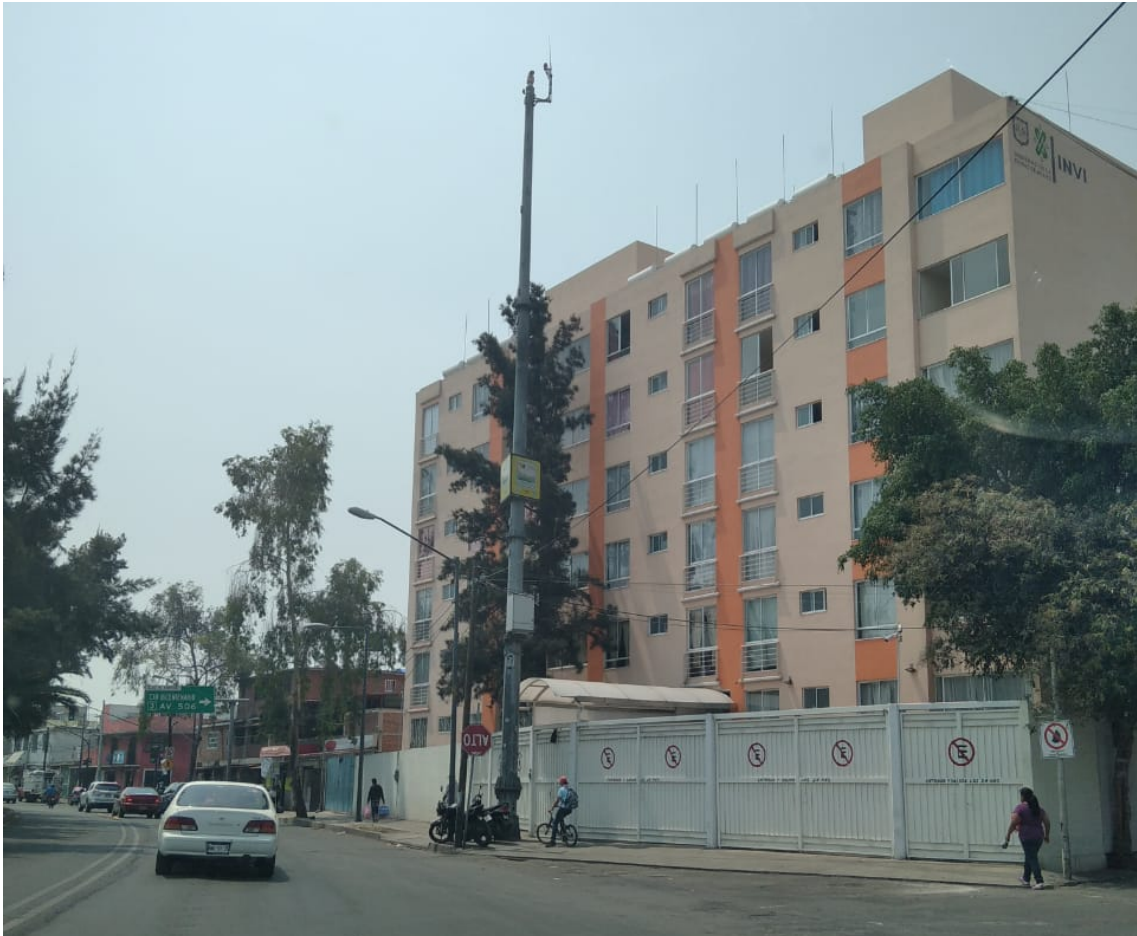
Fotografía 4. Edificio INVI en Calzada SJA.
