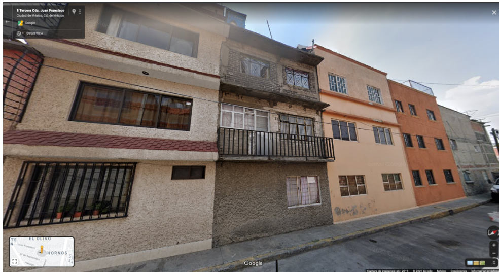
Fotografía 3. Vista de casa multifamiliar. Google Maps.
