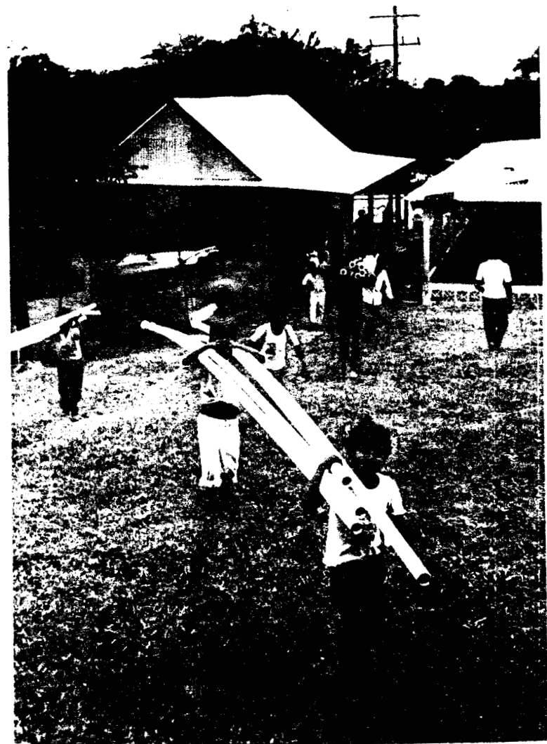
Durante la instalación de la red de agua potable, hasta los niños intervie- nen en la faena.
