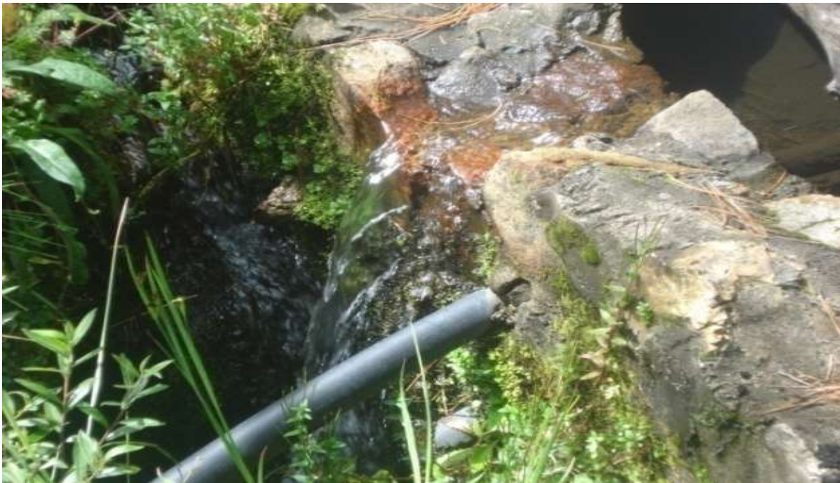
Figura 6. Presa de piedra acomodada de la cual se surte de agua superficial la colonia General Manuel Ávila Camacho con una manguera de 4" dejando correr la demás.
