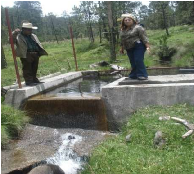
Figura 8. La comunidad de Ávila Camacho construyó un estanque para la captación de agua en el llano de Aculco, para poder bajarla por medio de la fuerza de gravedad, debido a que el llano de Aculco se encuentra a 15 km de distancia. Sin embargo, el agua del llano también se distribuye al Municipio de Santa Rita Tlahuapan, Estado de Puebla, por lo que
