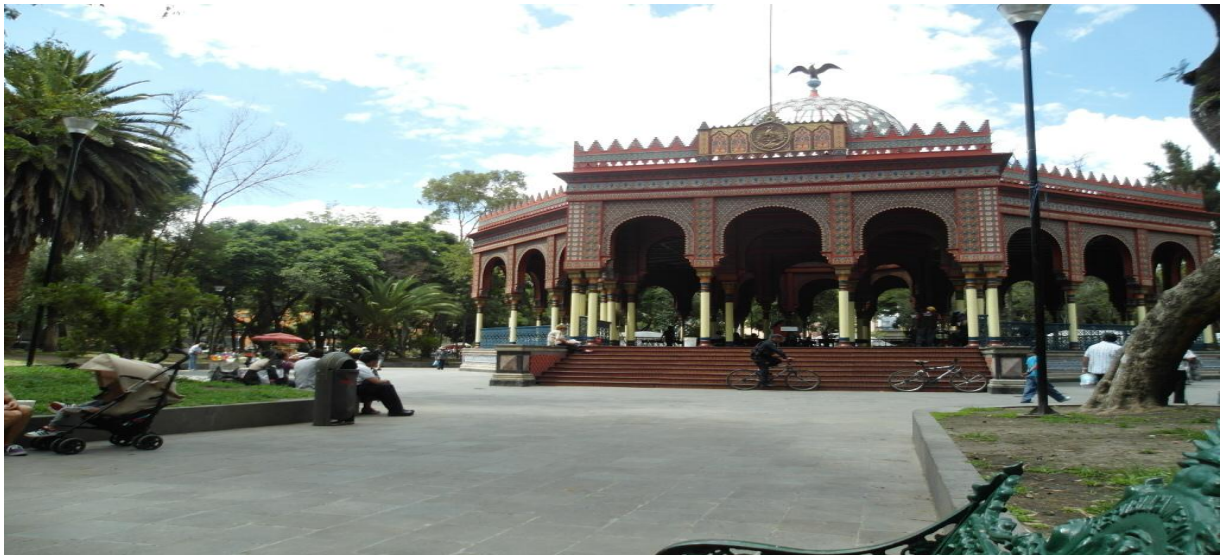
Fotografía 12. Kiosco Morisco en la Alameda de Santa María la Ribera.
