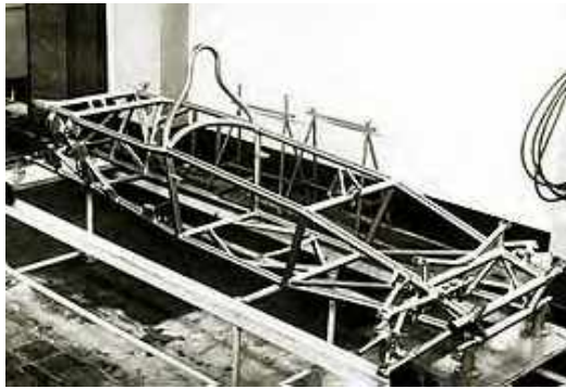
Gráfico 17 Chasis Tubular Automóvil de Fórmula 1 Ferrari 156 (1961)
