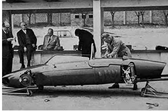
Gráfico 18 Carrocería de acero del automóvil Fórmula 1 de la Ferrari 156 (1961)
