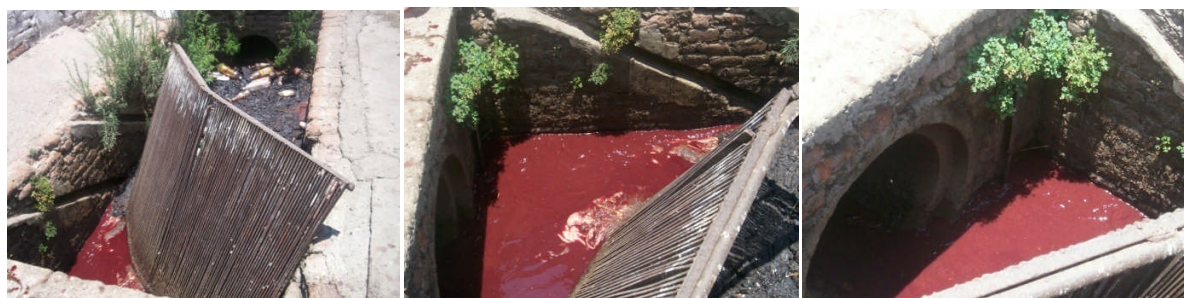
Figura 3.1. Secuencia del flujo de agua residual de rastro a través del registro a cielo abierto.
