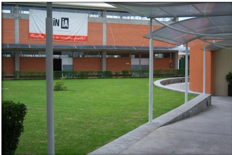
Imagen 8. Al fondo uno de los edificios de CINIA. Fuente: propia
