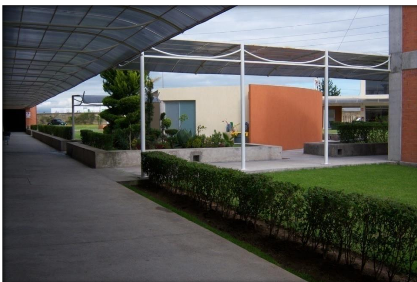
Imagen 11. Pasillo . Fuente: propia
