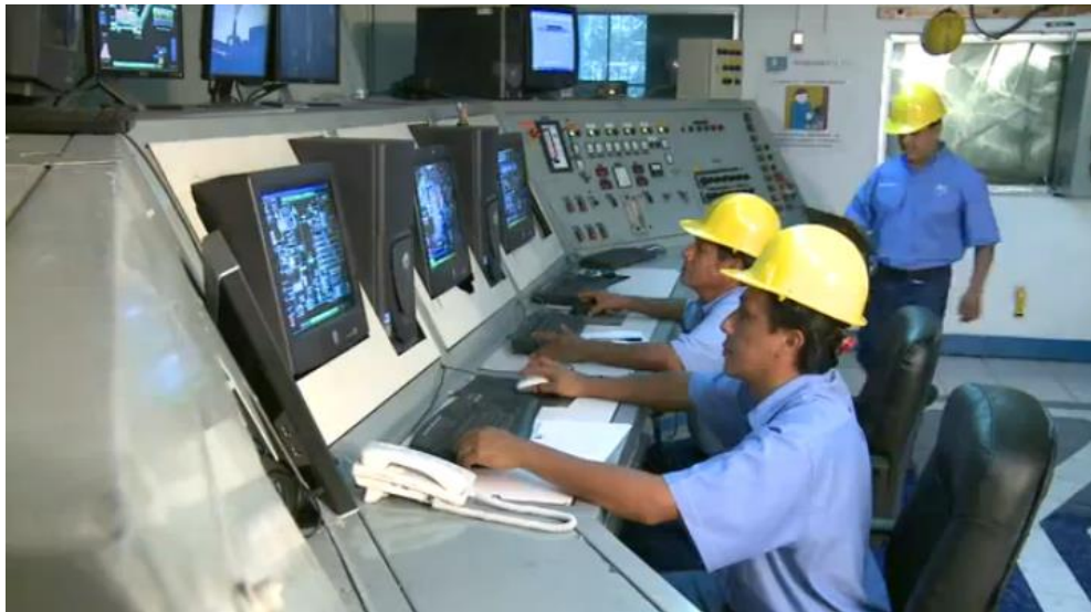
Planta de energía eléctrica
