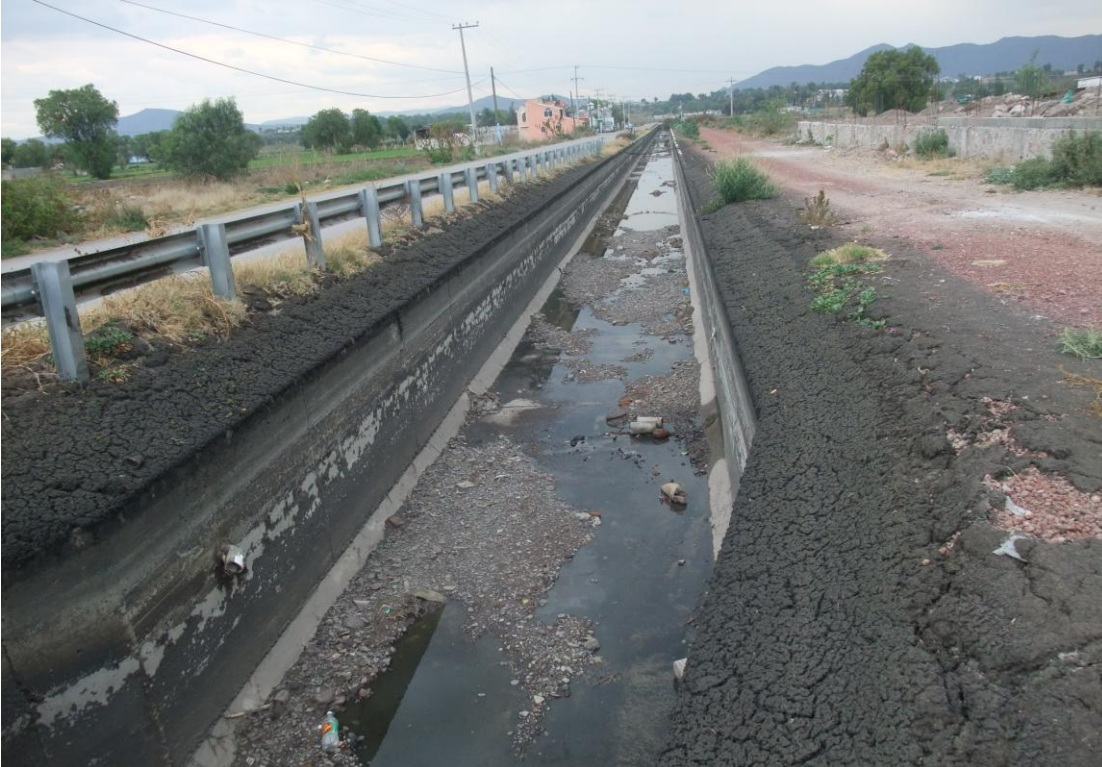
Figura. 4.7 Residuos de grasas y alquilbencilsulfonato en los canales, evidencias de la carga de contaminantes que transporta el agua residual a la altura del curso en Ixmiquilpan, Hidalgo.
