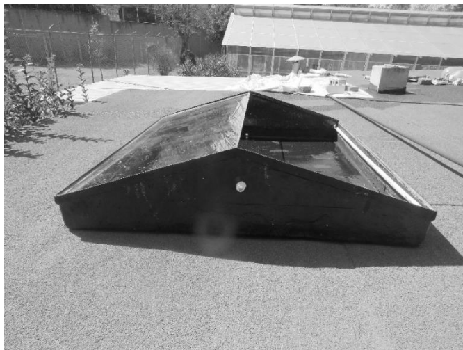
Figura 29. Dispositivo durante la colocación de los condensadores.
