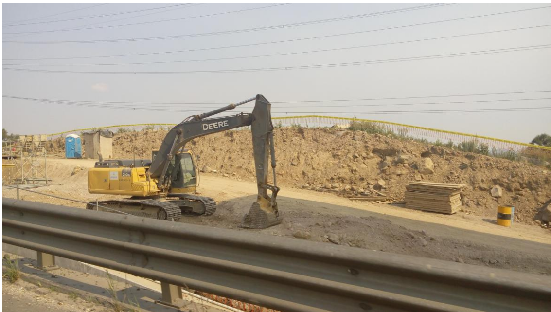
Imágenes 6.10 y 6.11. Algunas de las maquinas empleadas dentro de los trabajos de construcción y que es la principal fuente de emisión de contaminación sonora. Fuente: Trabajo de campo.
