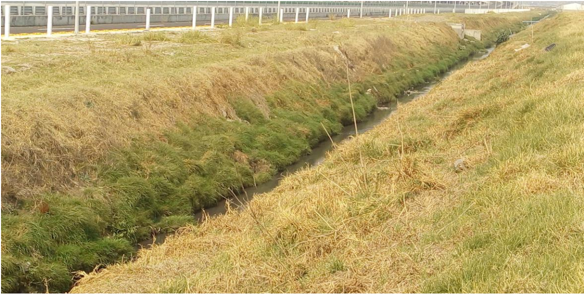
Imagen 6.4. Canal de aguas residuales cercanas a los campos de cultivo y del cual algunos agricultores refieren que utilizan como suministro de agua. Fuente: Trabajo de campo.
