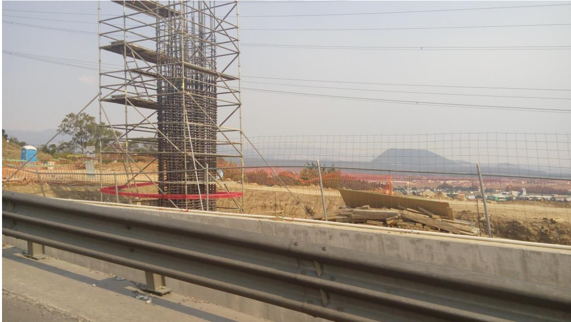
Imagen 4.3. Obras de construcción del tren interurbano de pasajeros paralela a la carretera México-Toluca, en el municipio de Lerma. Fuente: Trabajo de Campo.
