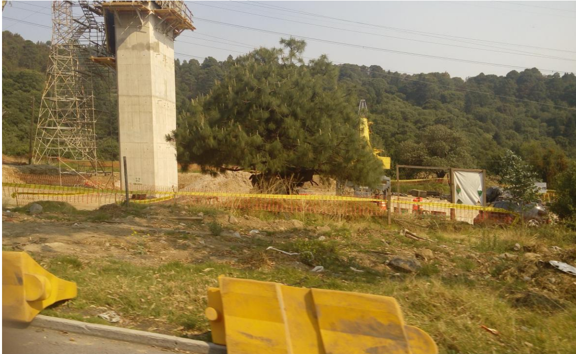
Imagen 5.7. Se observan algunos escombros derivados de la construcción y algunos árboles, que serán talados en un futuro, cuando se instale finalmente el tren. Fuente: Trabajo de campo.
