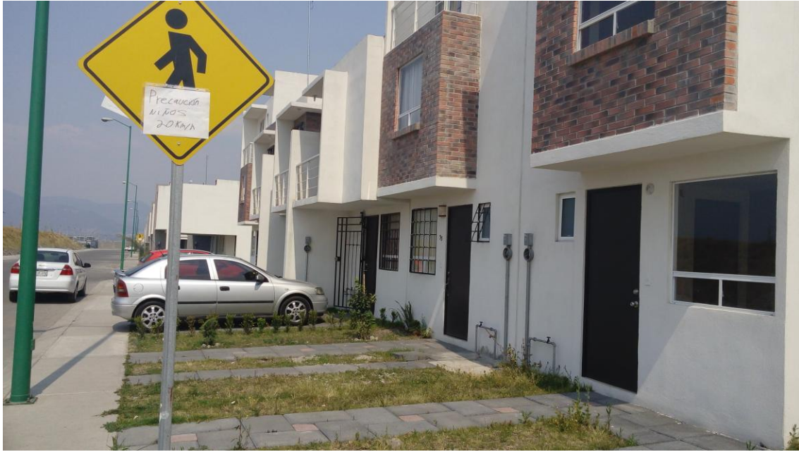
Imagen 6.9. Casas pertenecientes a una unidad habitacional cercana a las obras de construcción del tren y las cuales sufren las principales consecuencias de la contaminación sónica. Fuente: Trabajo de campo.
