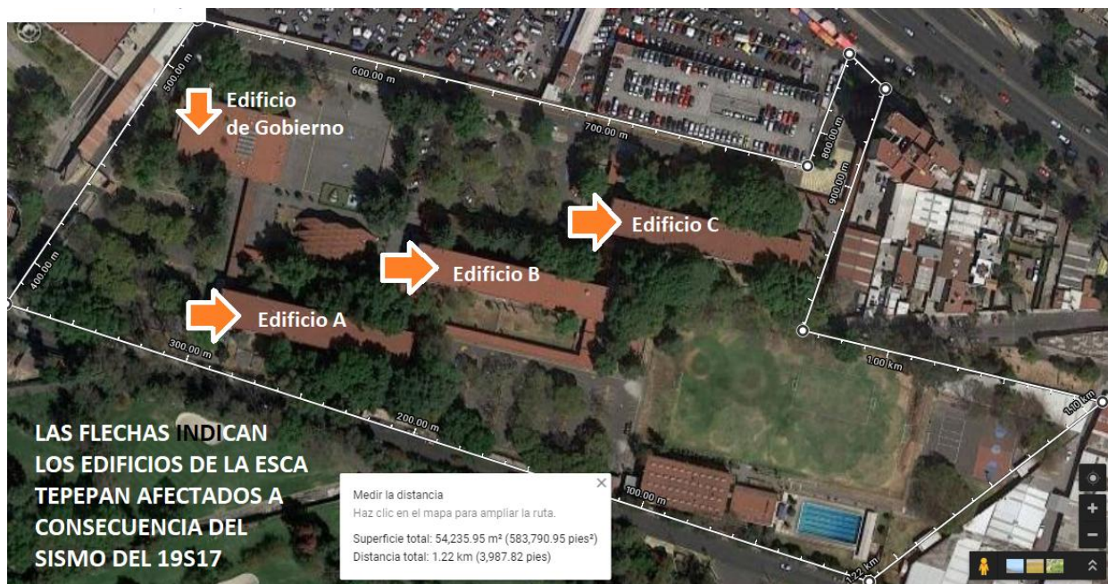
Imagen 6.2. Vista aérea de la ESCA Tepepan en que se señalan sus edificaciones afectadas a causa del sismo del 19 de septiembre de 2017. Fuente: Google maps. 2017.
