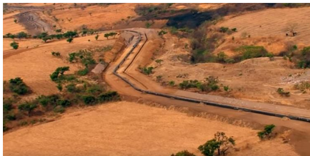
Fig. 6 Tuberías de gasoducto. Still de video Enrique Ochoa Reza, 2013.
