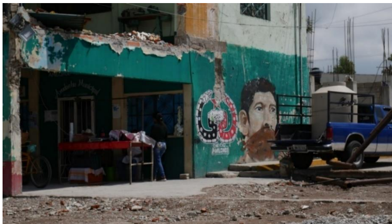
Fig. 26 Edificio de la antigua Ayudantía de Amilcingo. Foto E. Vogrig. 2023
