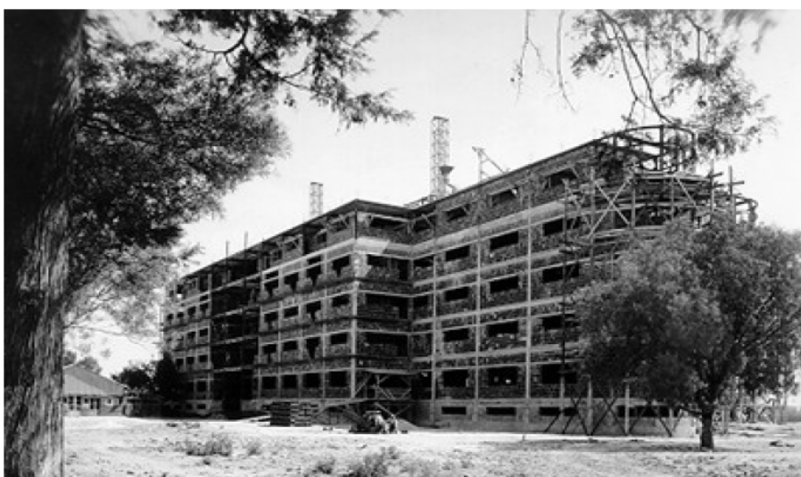
Fuente: Fototeca Nacional INAH, Hospital del Niño en construcción
