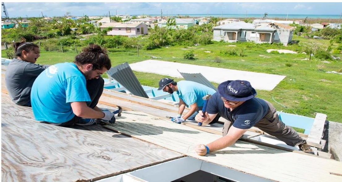
Reconstrucción de casas afectadas por el huracán en Antigua y Barbuda en el 2017.
