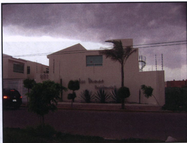
Conjunto Residencial, zona Periférico
