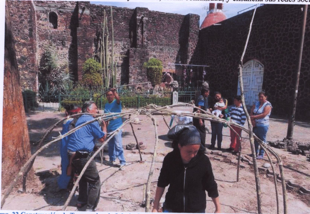
Img. 22 Construcción de Temazcal en la Iglesia de Atlazolpa. El cuerpo fue hecho de Carrizos y se forró con plástico negro. Foto: M.R.B.
