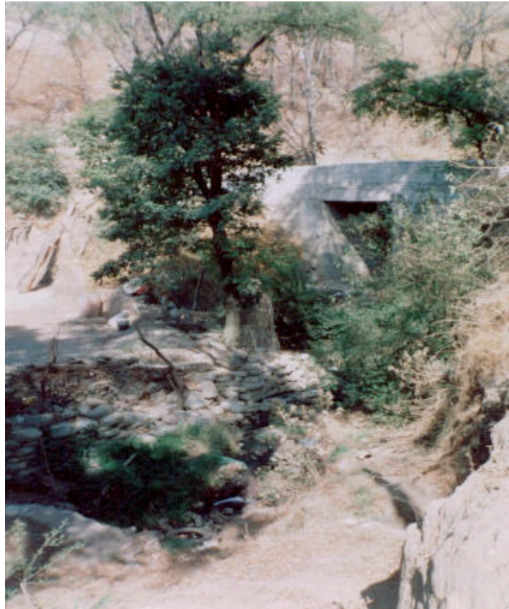
Foto #3 vista donde pasa el drenaje en el paraje Zacatal
