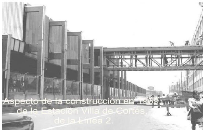
Aspecto de la construcción en 1969 de la Estación Villa de Cortés de la Línea 2. En la imagen se observa la Calzada de Tlalpan a la altura de la Estación Villa de Cortés. [Fotografía de la página web: http://data.metro.cdmx.gob.mx/organismo/construccion.html administrada por el STC, Metro].
