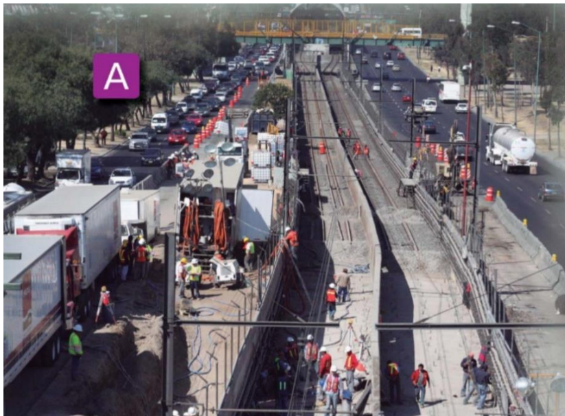
La imagen muestra una parte de la calzada Zaragoza, se observa el trabajo de los obreros para realizar lo que ahora es la línea A. [Fotografía de Araceli López encontrada en el libro “El metro es de todos” , página 41.]
