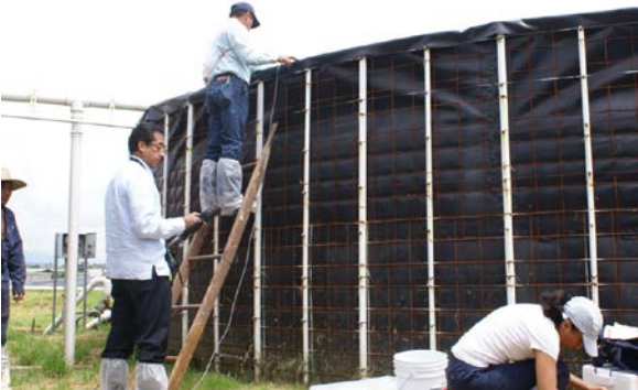
Tanques de Aireación
