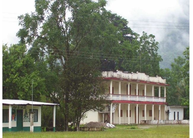
Salón ejidal y casa de salud
