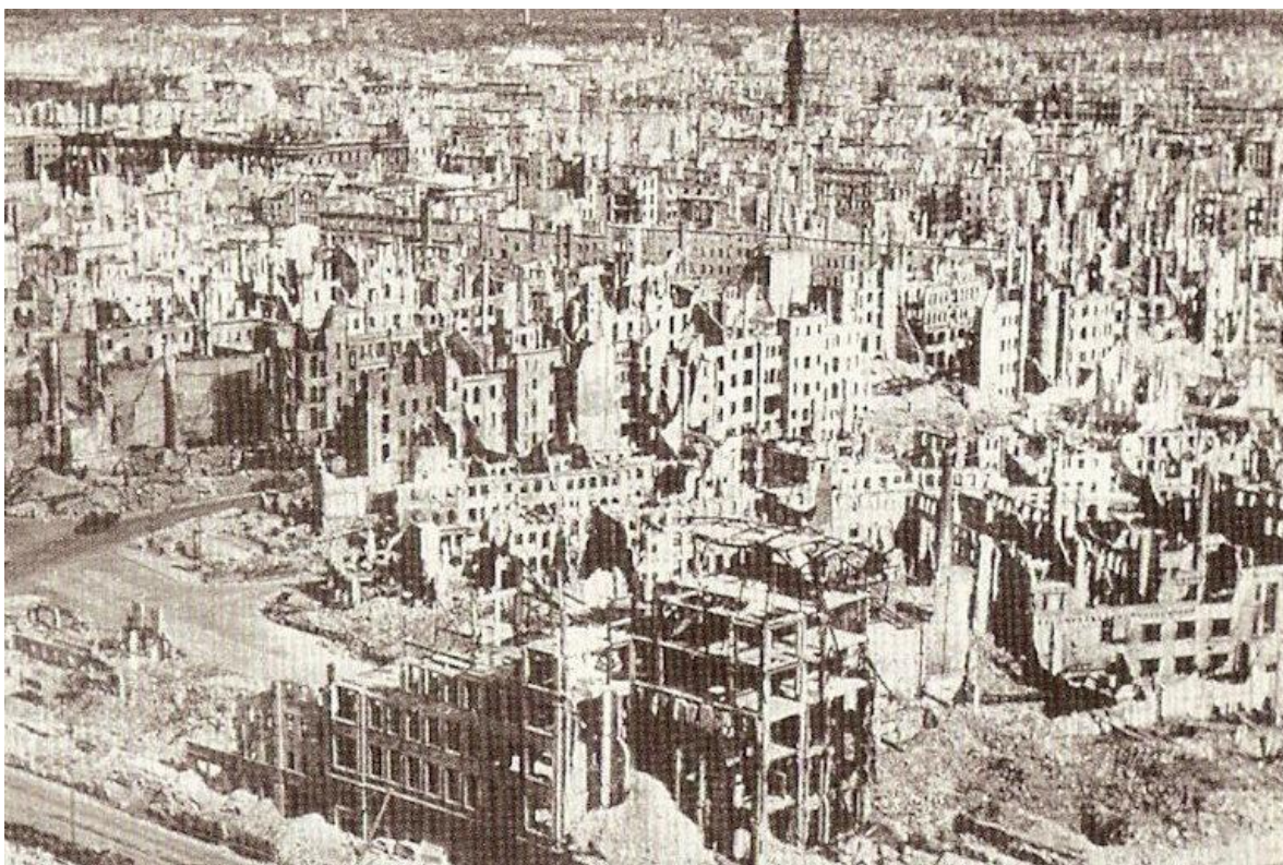
Foto 27. Se observa la destrucción de un barrio entero en Dresde.
