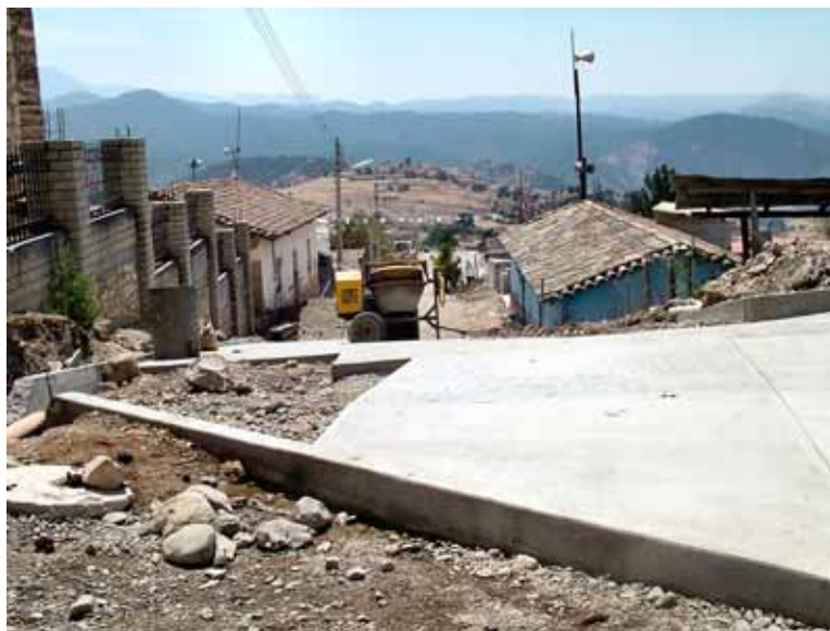
Pavimentación de la calle Porfirio Díaz, Santa María Tindú.
