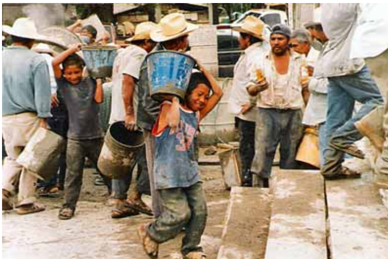
Construcción de casas, Santa María Tindú.
