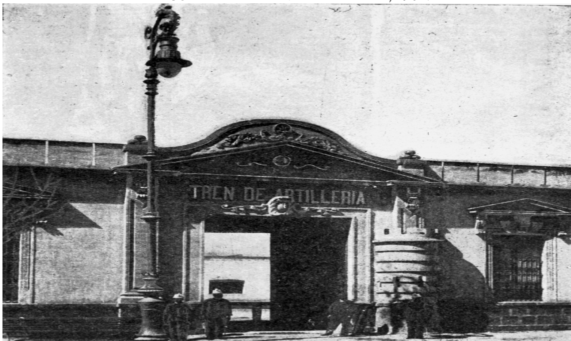
IMAGEN NO. 3.8 EL CUARTEL DEL TREN DE ARTILLERÍA, 1901.
