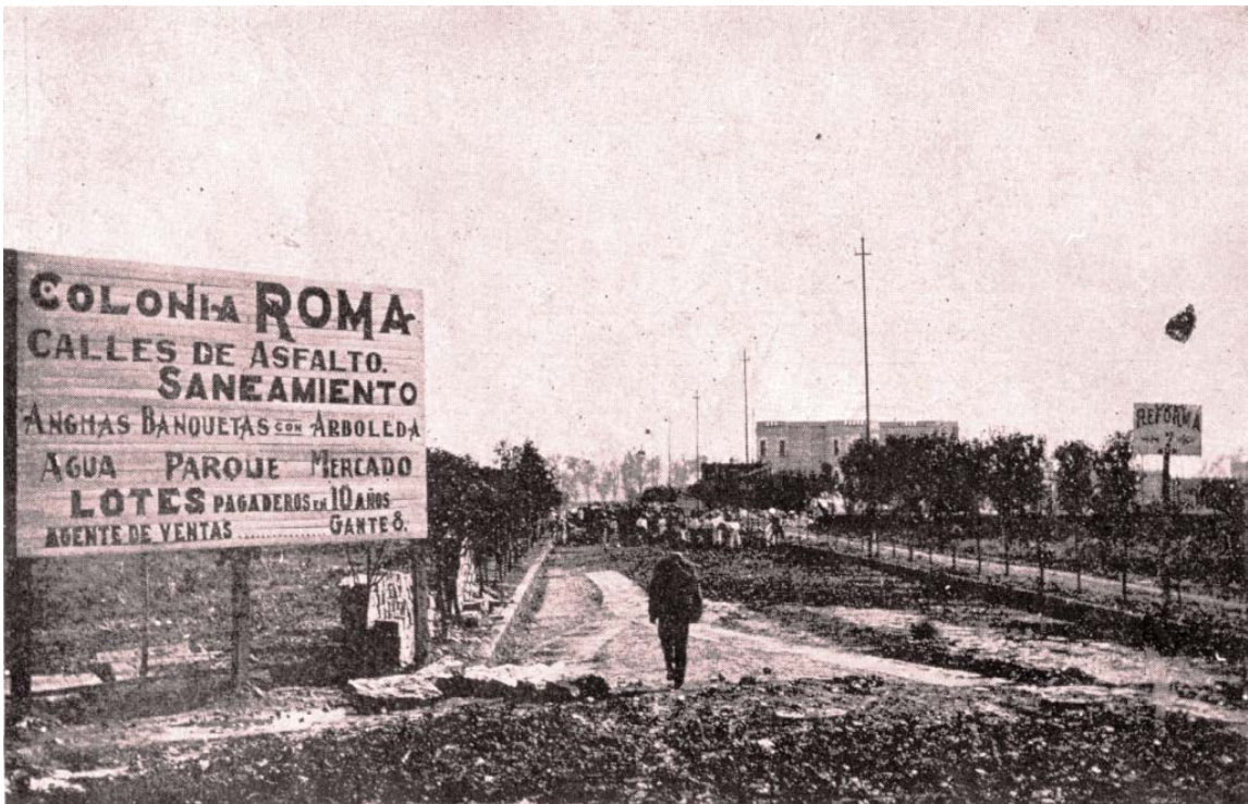
IMAGEN NO. 1.2.3.3 TRABAJOS DE URBANIZACIÓN DE LA “COLONIA ROMA”
