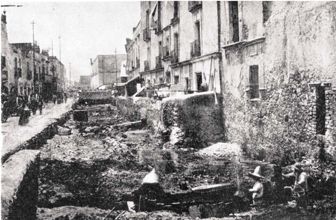
IMAGEN NO. 1.1.6 LOS TRABAJOS EN LA CALLE DE ROLDAN.
