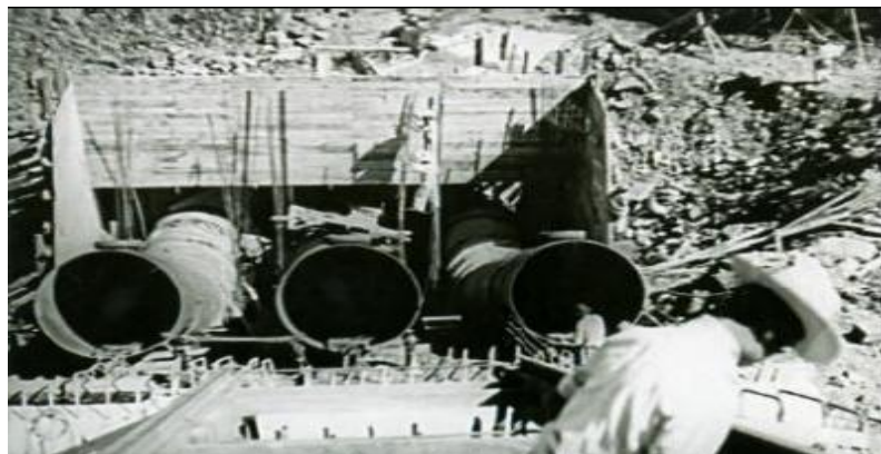
Fig.5.- Tubería de Fuerza de Planta de Patla
