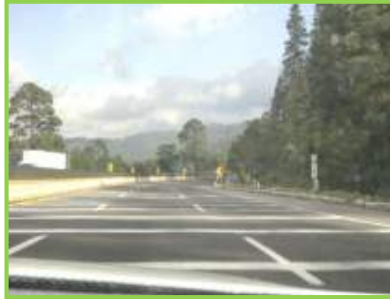
3.11. Autopista México – Puebla.
