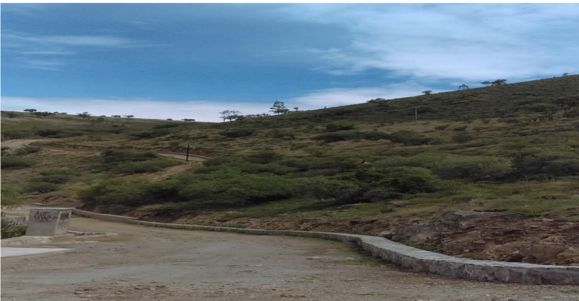
Imagen #12. Fotografía del camino que conduce a la cima del Elefante. Para realizar la construcción de este camino se tuvo que emparejar y anchar (quitar árboles y nopaleras) por lo menos unos cuatro kilómetros de tierra. Fecha de captura 12/05/18.
