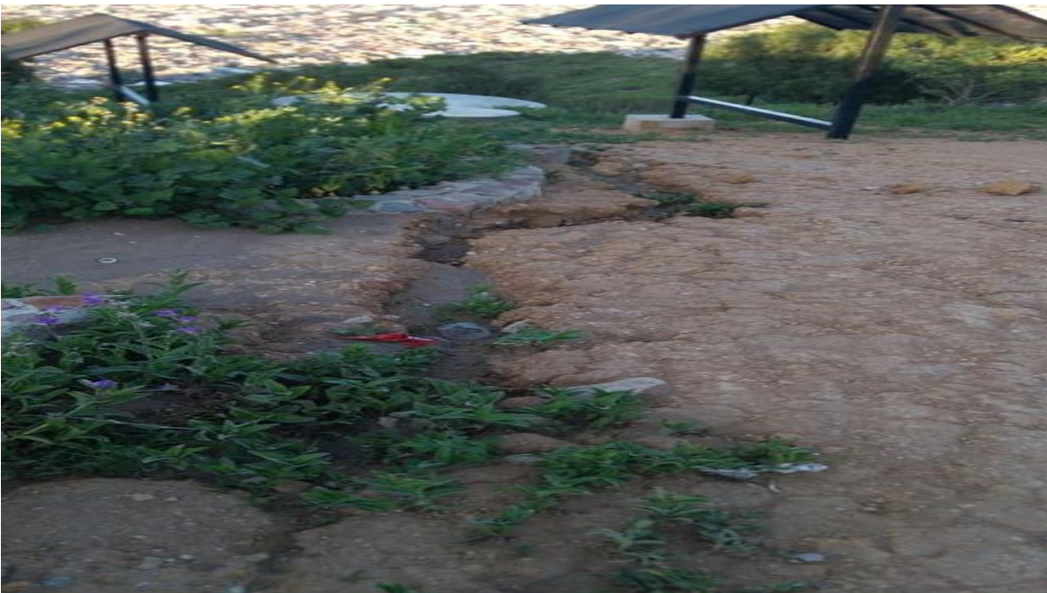
Imagen #20. Esta imagen muestra los efectos antrópicos en la tierra, en este caso se observa una grieta en la tierra provocada por el agua, al fondo se puede apreciar dos palapas construidas en la cima del Elefante. Fecha de captura 21/07/18.
