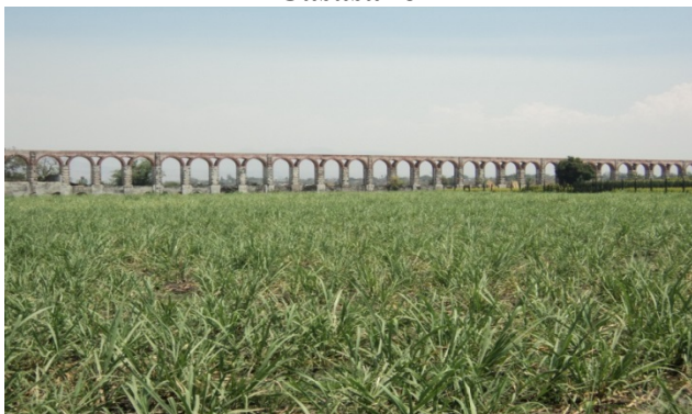
Fotografía No. 4. Acueducto en el ejido de Casasano
