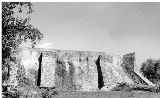
Fotografía No. 3. Represa de irrigación, manantial “Las Tazas”
