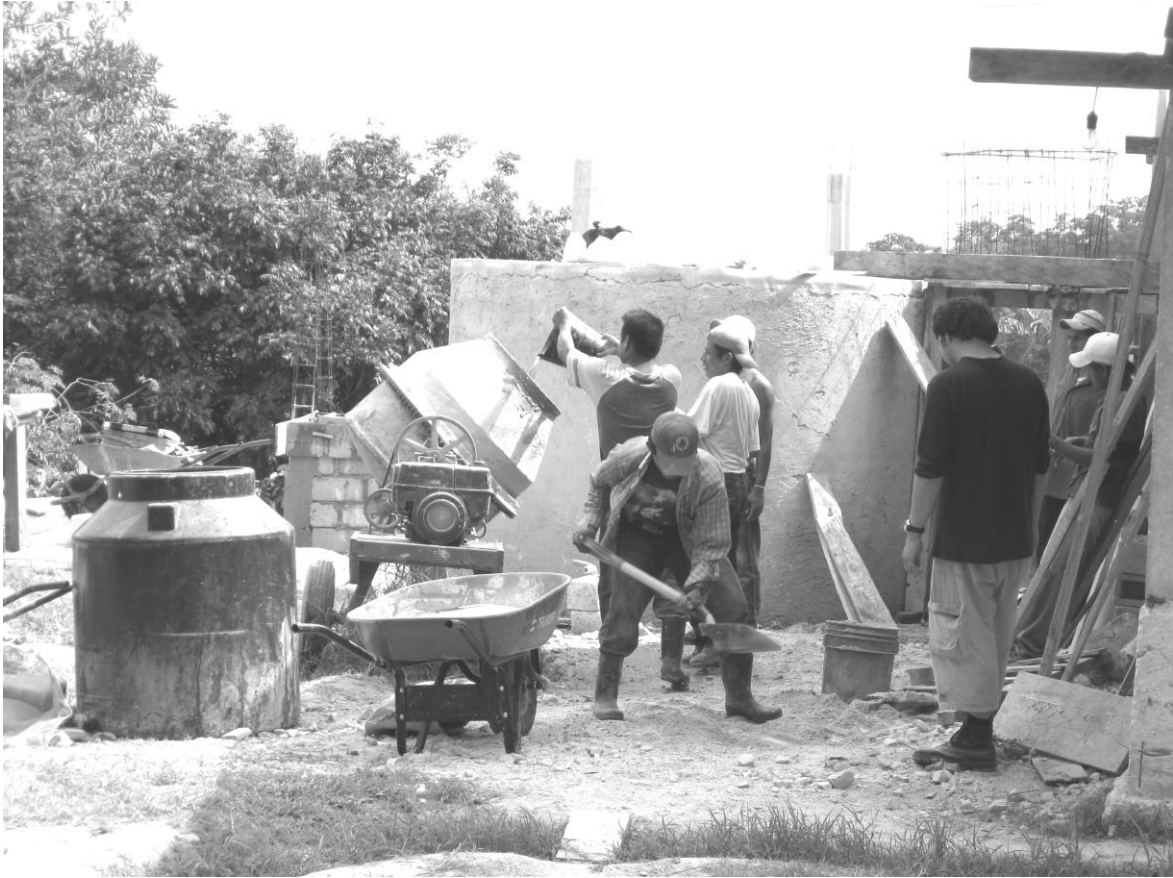
Castigados y brigadistas italianos construyen juntos una cisterna para la potabilización del agua, Caracol de La Realidad, enero 2009.
