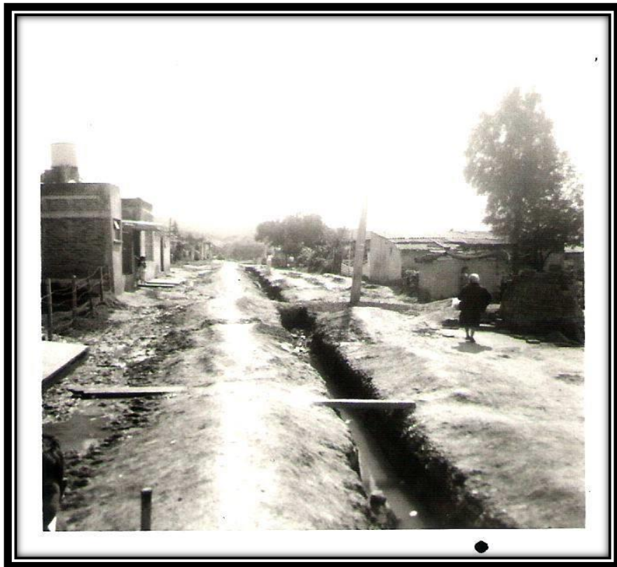
Calle del Moral, década de los setenta, excavación para colocar tomas de agua potable.
