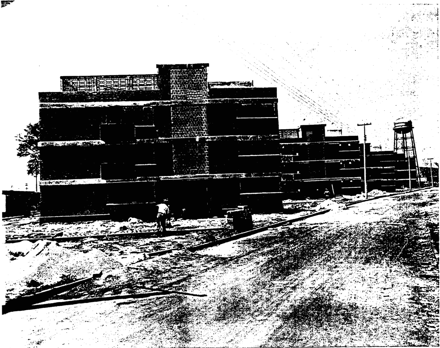
Toma fotográfica de "Los Multifamiliares del IMSS en Ayotla". que comprende el edificio 1, 2, 3 y 4 constituidos por doce departamentos cada uno así como el tanque elevado de almacenamiento de agua potable que abastece a las 700 familias de la unidad, 19 de noviembre de 1958.
