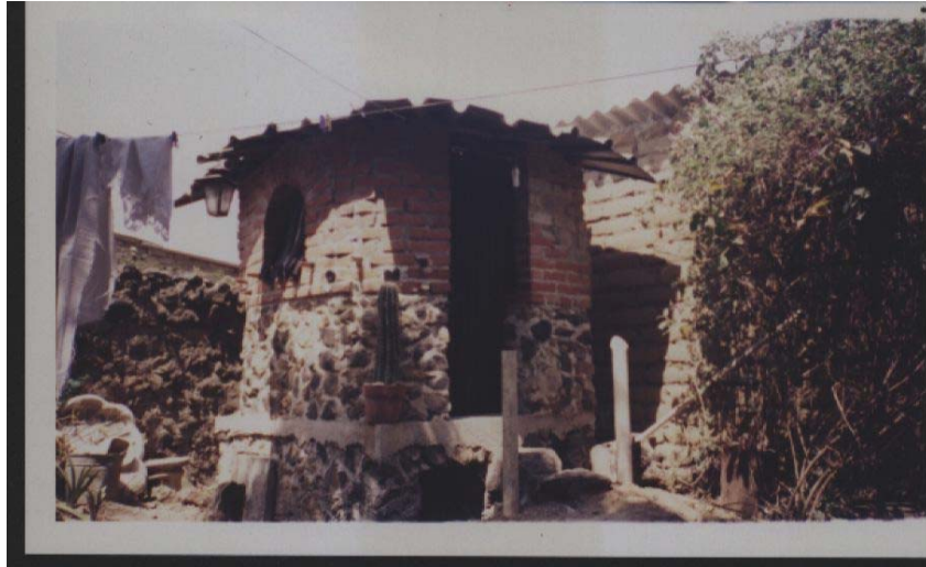
Una ecotécnia; baño en seco, para ahorrar y no contaminar el agua, (en uso)
