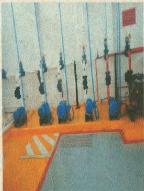
Figura 3.3 Bombas para surtir agua
