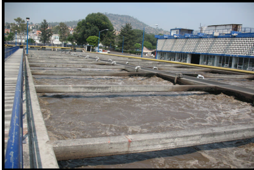
Figura 2.9 Planta de tratamiento de aguas residuales “Cerro de la estrella”.
