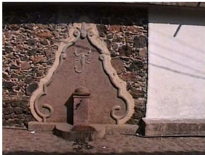
Toma de agua, barrio de San Sebastián
