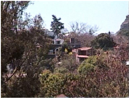
Casa, Zona centro
