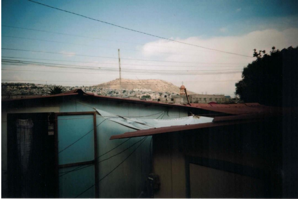
Figura 37. Pasillos a cielo abierto.
