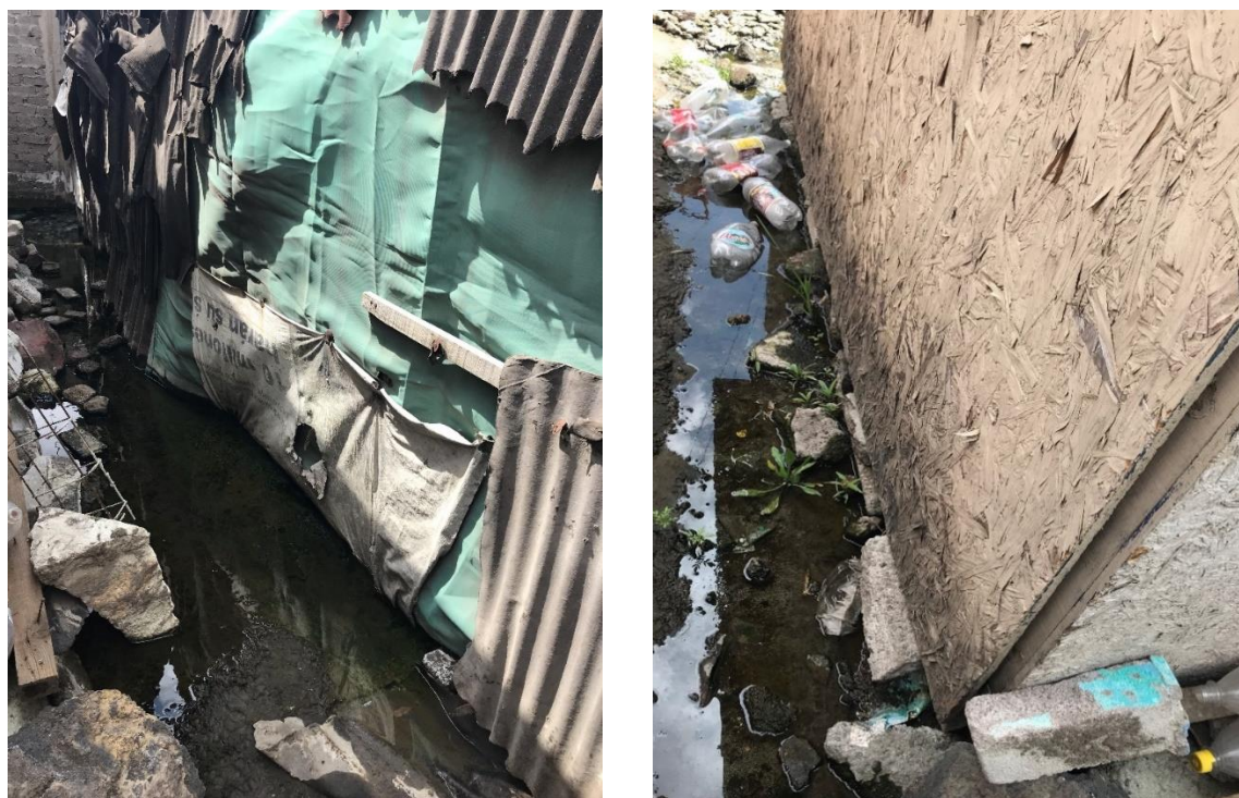
Figura 33. Materiales de la autoconstrucción suspendida III y IV.
