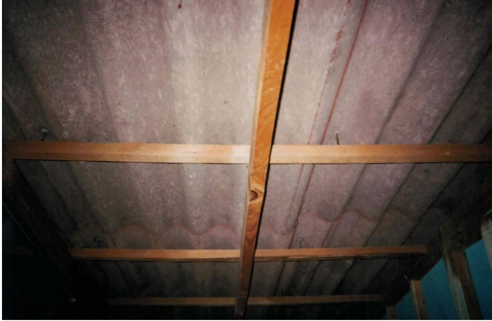
Figura 20. Materialidad de la autoconstrucción suspendida I: techo de lámina.
