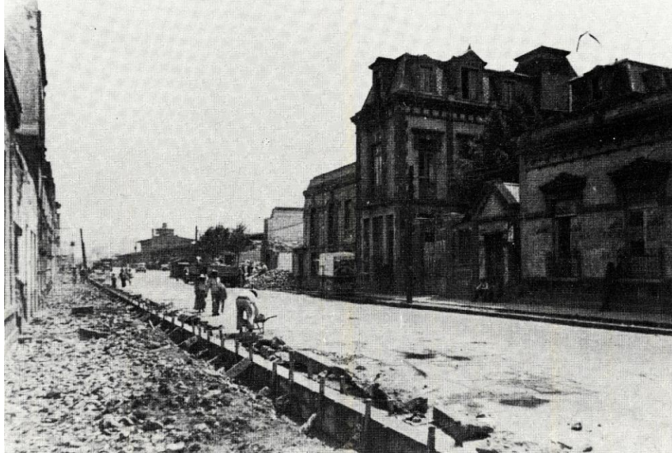
“Construcción de banquetas en la calle de olivo, colonia Santa María la Ribera, 1930”
