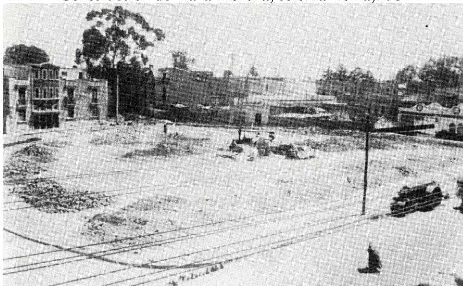
“Construcción de Plaza Morelia, colonia Roma, 1932”
