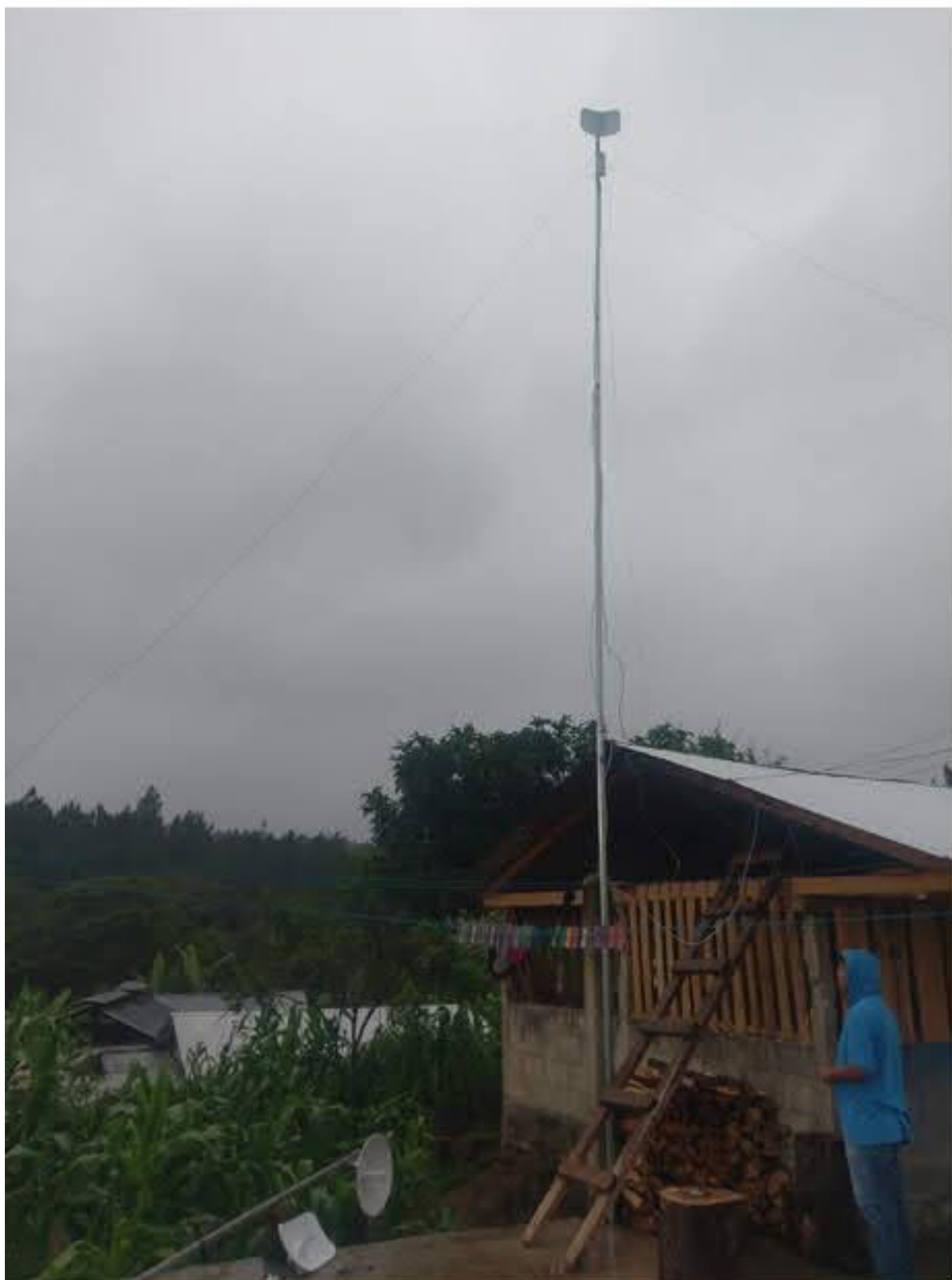
Imagen 19. Reemplazo de Antena. Abajo las antenas viejas; arriba las antenas nuevas (el objeto rectangular debajo del que está en la punta, es también una antena)
