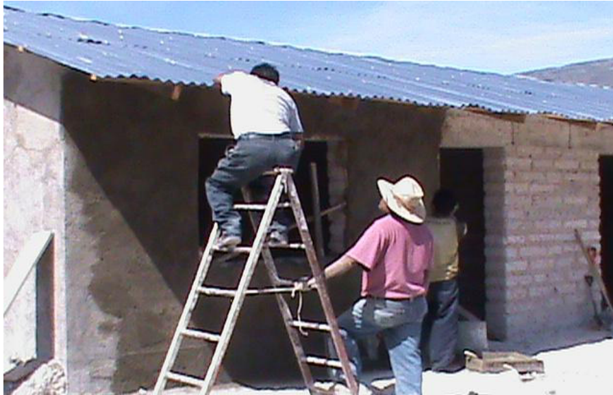
Fig.14. Renovación de la escuela primaria VEE SAVI 2011.
