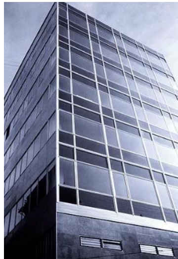
Figura 8. Instalaciones. Fuente: Google Maps (2017).
