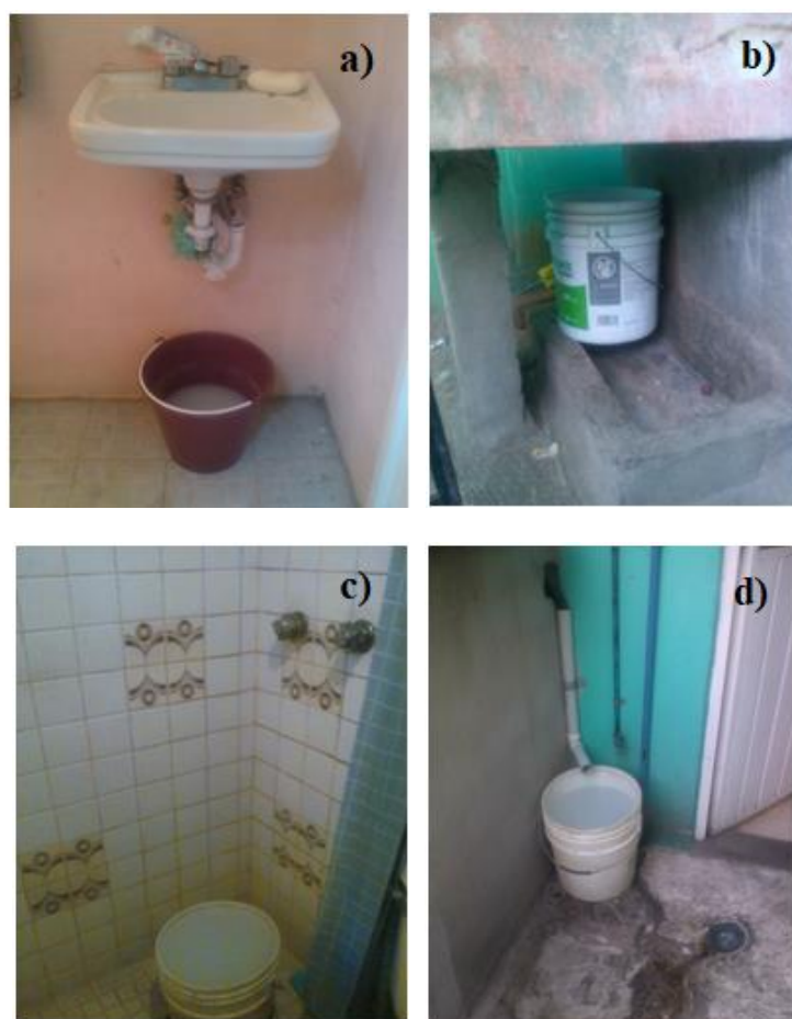
Figura 4.2. Almacenamiento de las aguas grises de: a) lavamanos, b) aguas de cocina, c) regadera, d) lavadora.
