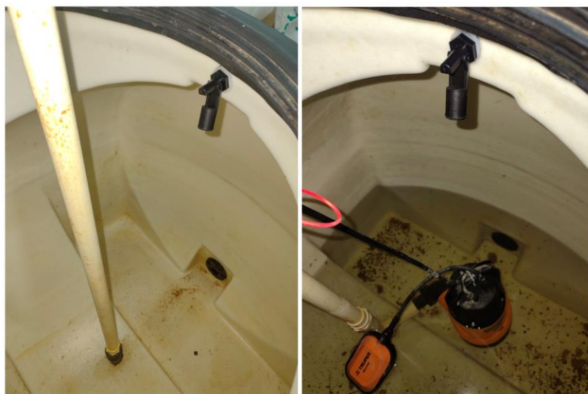
Figura 38 Conexión sensor nivel
