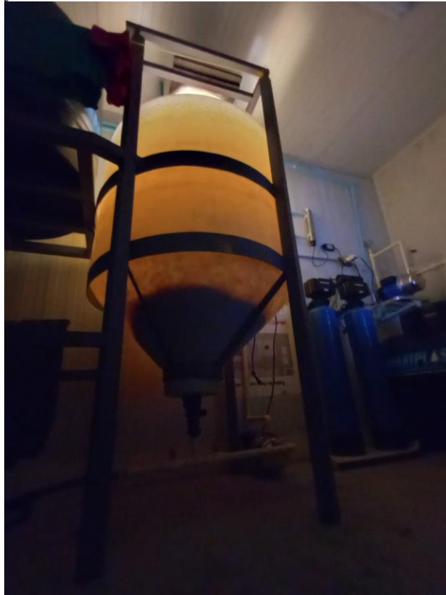
Figura 14 Formación de flóculos en la tolva
