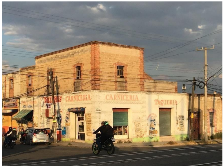
Fotografía 10. Autoría propia. Sin título. 2020. Este edificio abarca toda una cuadra y se encuentra en contra esquina con el centro industrial férreo, a lado de la vía que conduce a Veracruz. Como se observa, la planta baja ha sido adaptada para el comercio, mientras que la parte superior es para uso privado, la cual conserva su diseño original.
