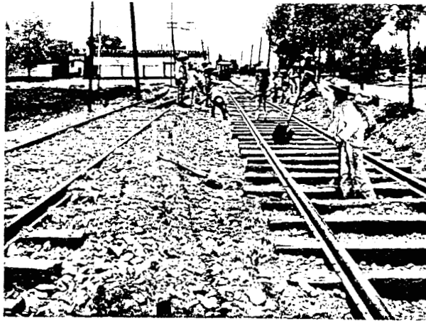
Mantenimiento de líneas tranviarias.
