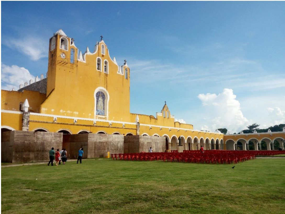
Fachada interna del convento de San Antonio de Padua. Octubre 2017.
