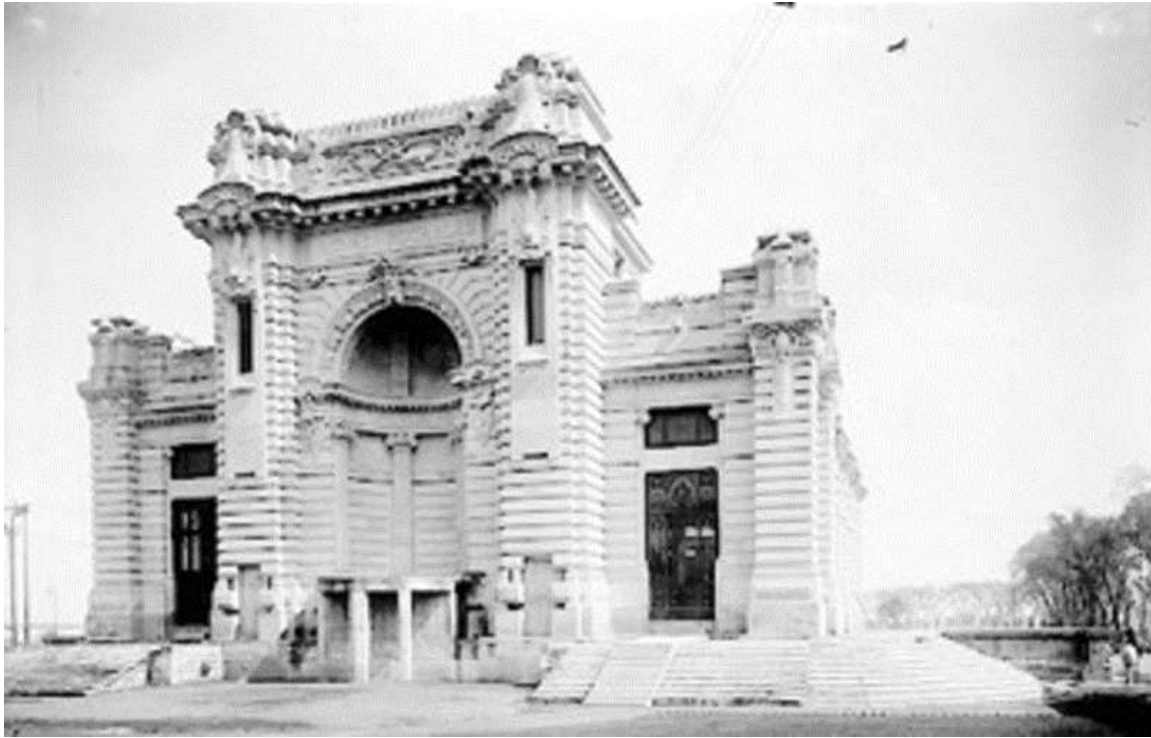
Figura 2.4 Casa de Bombas de la Condesa
