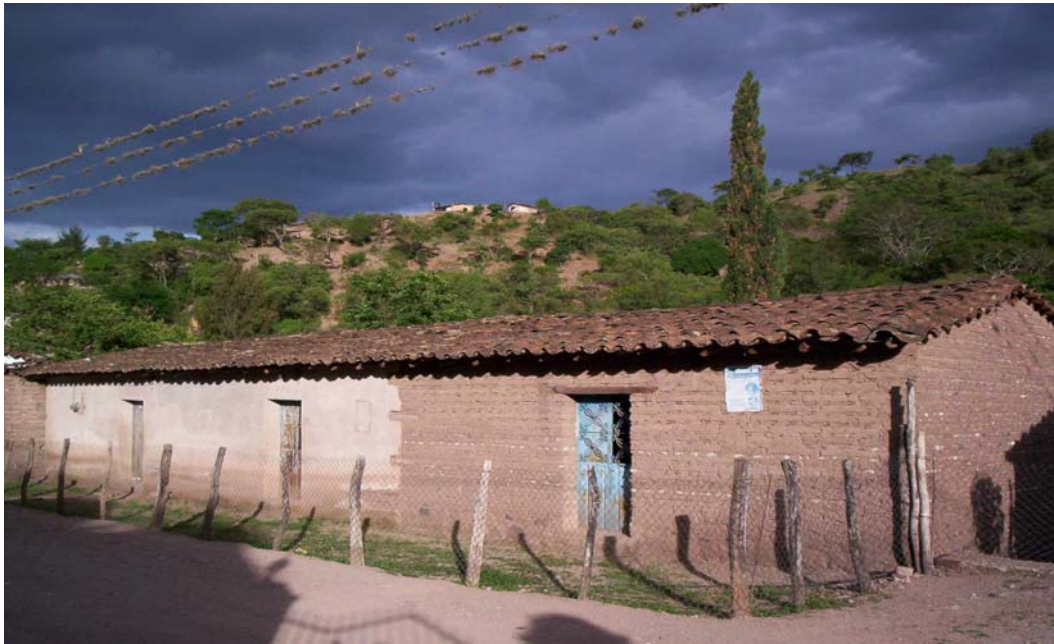
Casas de Adobe y Casas de Material.
