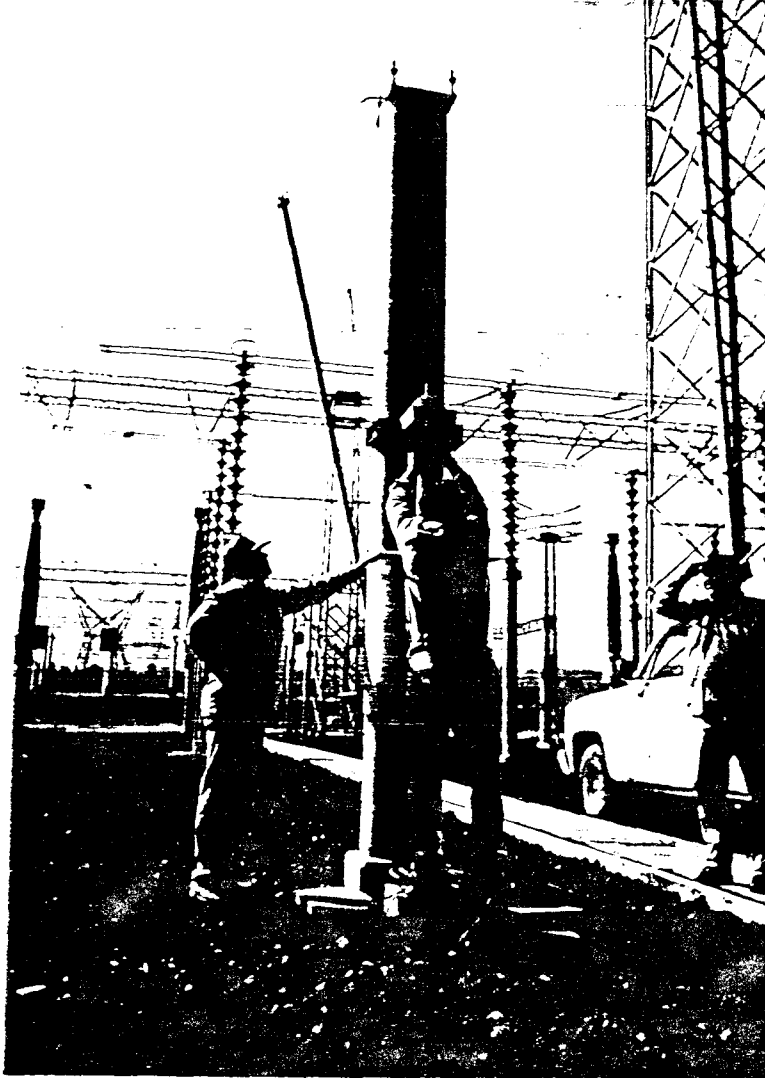
Trabajadores de mantenimiento durante una reparación
