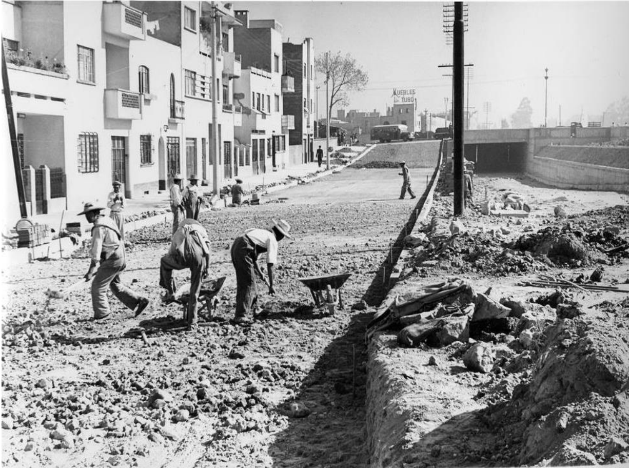
(Foto 6. Fotografía tomada en Tlalpan Historia ). Construcción Viaducto Tlalpan e Insurgentes, 1952.
